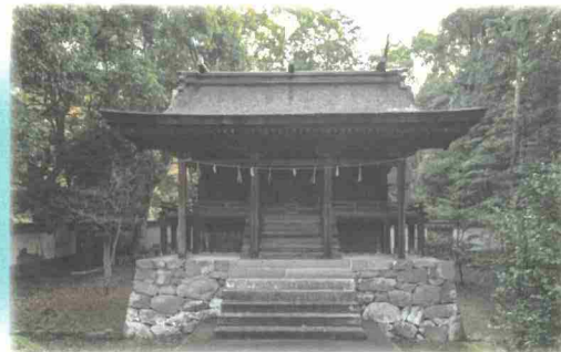
約800年前に建てられた美しい屋根の社殿
